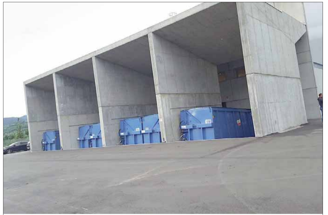
La piattaforma per la gestione dei rifiuti di AmAmbiente a Cirè di Pergine Valsugana
